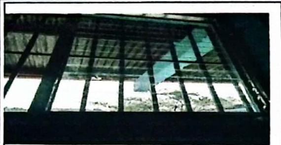
Foto1: sustitución de ventanas de 1.70 metros de alto x 3.50 metros de ancho, de aluminio con paleta y vidrio de 6 mm
