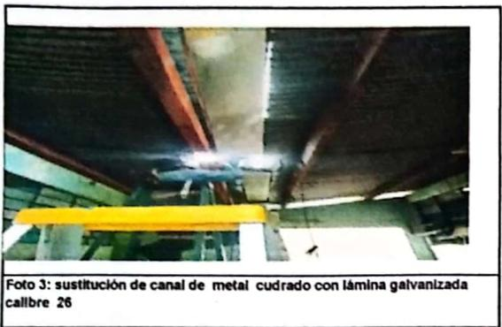
Foto 3: sustitución de canal de metal cuadrado con lámina galvanizada calibre 26
